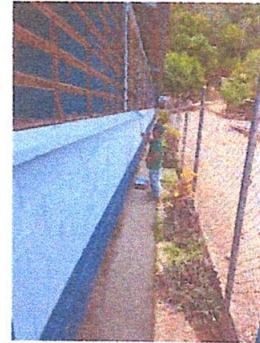
Foto 2: Aplicando pintura de exteriores.
