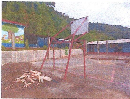
Foto 3: Columnas de los laterales finalizadas.
